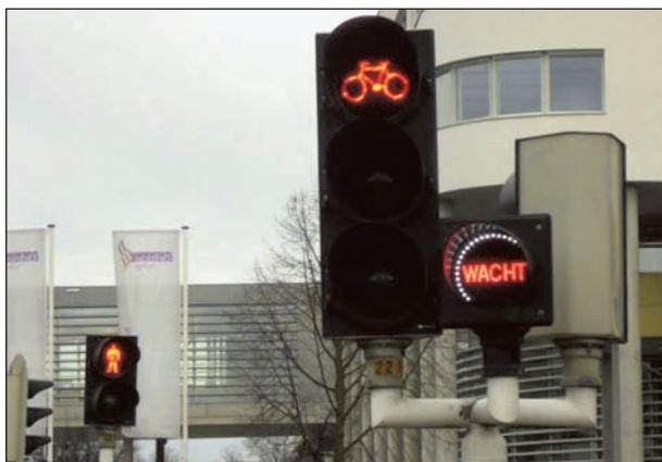
**Bild 3-18:** Count-Down-Anlage in Zwolle in den Niederlanden (BOLTZE, KITTLER, NAUKAMURA 2008)
