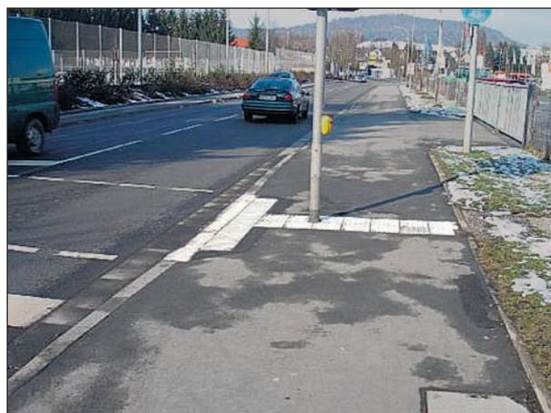
**Bild 3-29:** Auffindestreifen zum Signalmast in Hofgeismar (Hessen)
