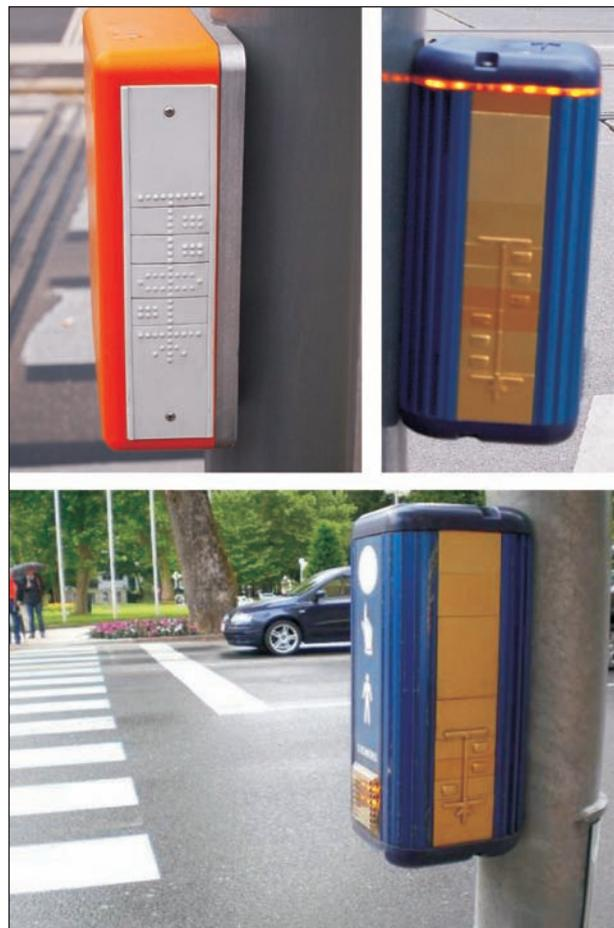
**Bild 3-31:** Taktile Zusatzinformation über Anzahl und Lage der Fahrstreifen in Wien (oben) und Spittal, Österreich (unten)
