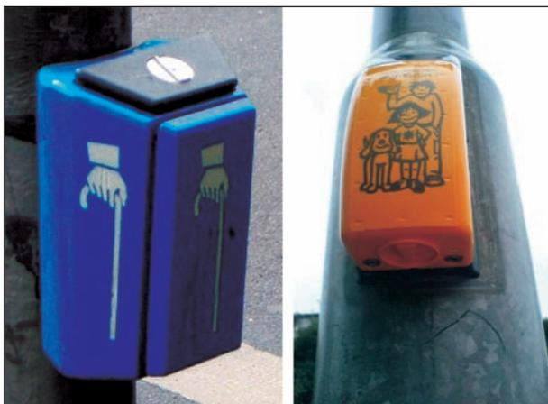
**Bild 3-30:** Taktile Zusatzinformation über die Gehrichtung in Düsseldorf, Nordrhein-Westfalen (links) und in Darmstadt, Hessen (rechts)
