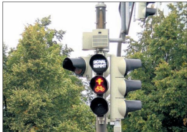
**Bild 3-4:** LSA mit Bestätigung am Mast
