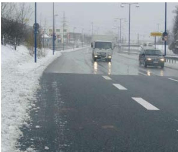
Abbildung 15: Übergang von einer geschlossenen Fahrbahn-decke zu einer offenporigen Deckschicht bei Nässe (Foto Kühne)
