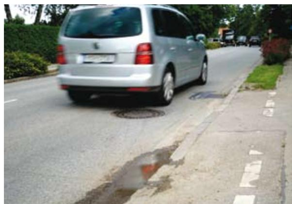
Abbildung 20: Kanaldeckel in der Rollspur als zusätzliche Schallquelle (Foto Kühne)
