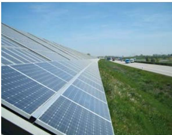
Abbildung 39: Lärmschutzwall mit aufgesetzter Photovoltaikanlage (Foto Kühne)
