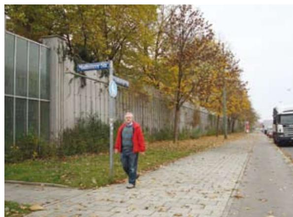
Abbildung 25: Lärmschutzwand entlang einer innerstädtischen Hauptverkehrsstraße (Foto Kühne)
