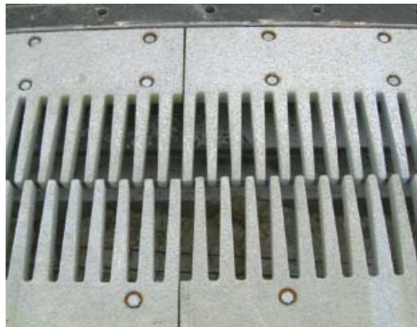
Abbildung 19: Übergangskonstruktion Brückenfuge „Finger“ in Fahrtrichtung (Foto Müller-BBM GmbH)
